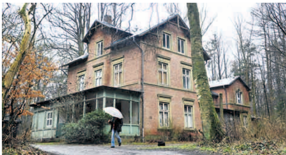
Inmitten des Niendorfer Geheges steht dieses Gebäude. Im Erdgeschoss gibt es noch einen Mieter, der wohl ausziehen muss
